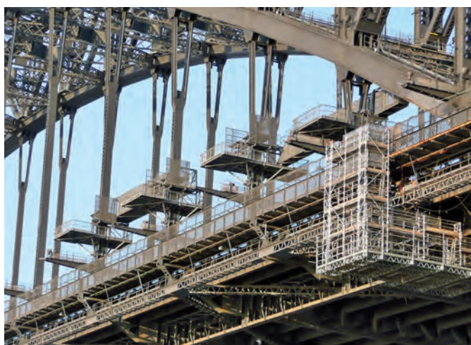
Prace konserwacyjne przy wieszakach i pomoście konstrukcji
