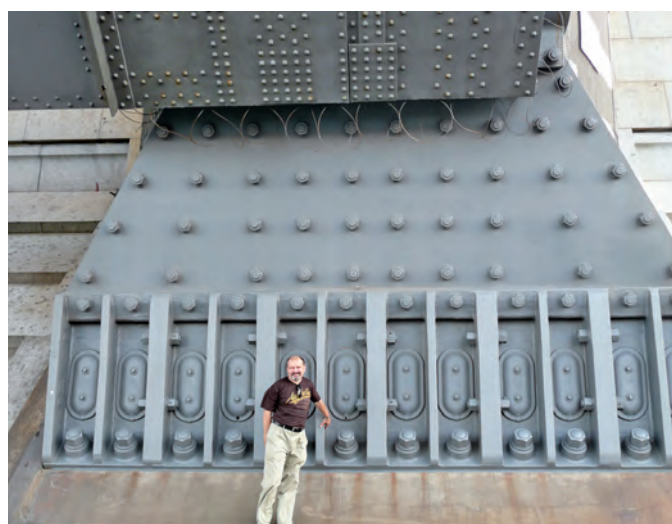
Autor artykułu na tle mostu, postać człowieka umożliwia ocenę wielkości przegubu łuku
