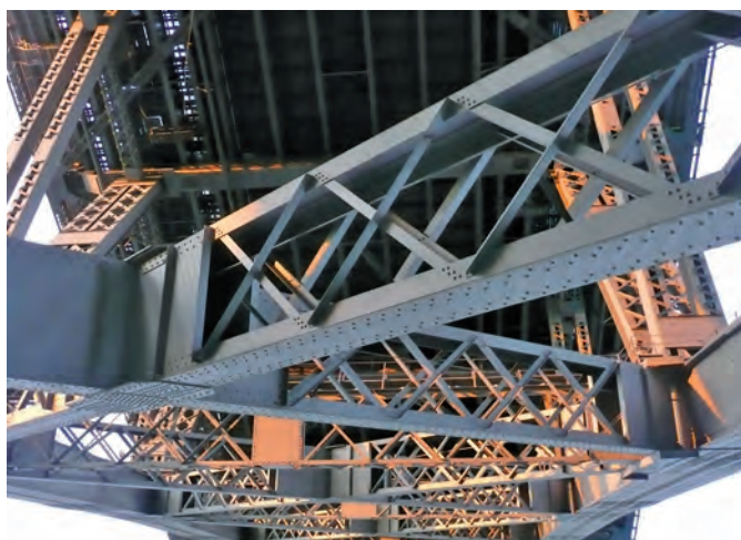
Ogrom konstrukcji stężeń poziomych przęsła łukowego
