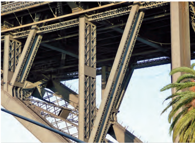
Koronkowa konstrukcja słupków i krzyżulców łuku
