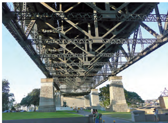
Widok konstrukcji południowej części dojazdowej od spodu
